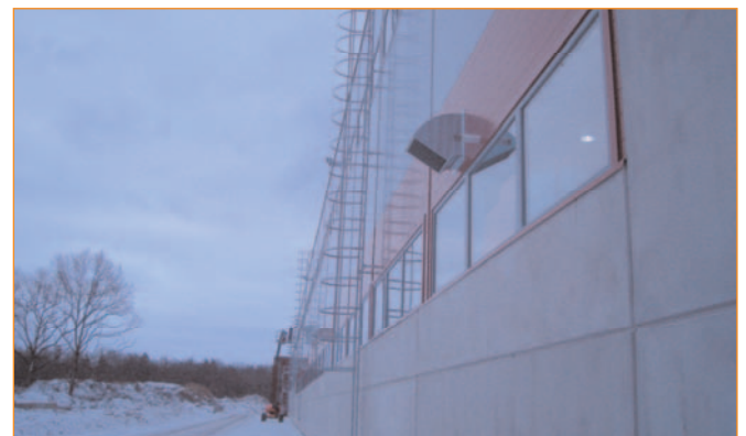
Бетонный завод, Эстония
