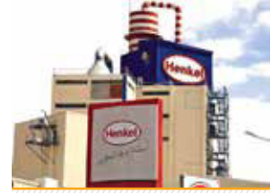
Завод строительных смесей Henkel, Ставропольский край
