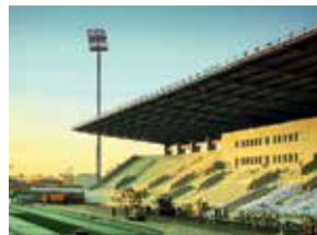
Стадион Труд, г. Подольск
