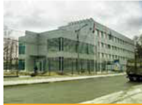
Завод Линде Газ Рус, Калужская обл.
